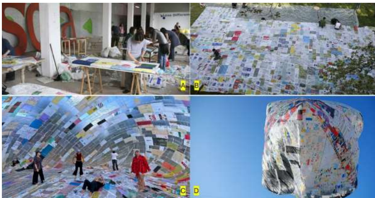
Figura 4. Proceso participativo y despliegue del Museo Aero Solar . A) Acopio y recolección comunitaria de bolsas de plástico reutilizadas. B) Taller colectivo de corte, pegado y personalización gráfica de la membrana plástica. C) Captación térmica e inflado de la estructura mediante la energía radiante del sol. D) Escultura aerosolar en su fase final de flotación y experiencia inmersiva espacial. Fuente: Adaptado de Aerocene Foundation, https://aerocene.org/museo-aero-solar .
